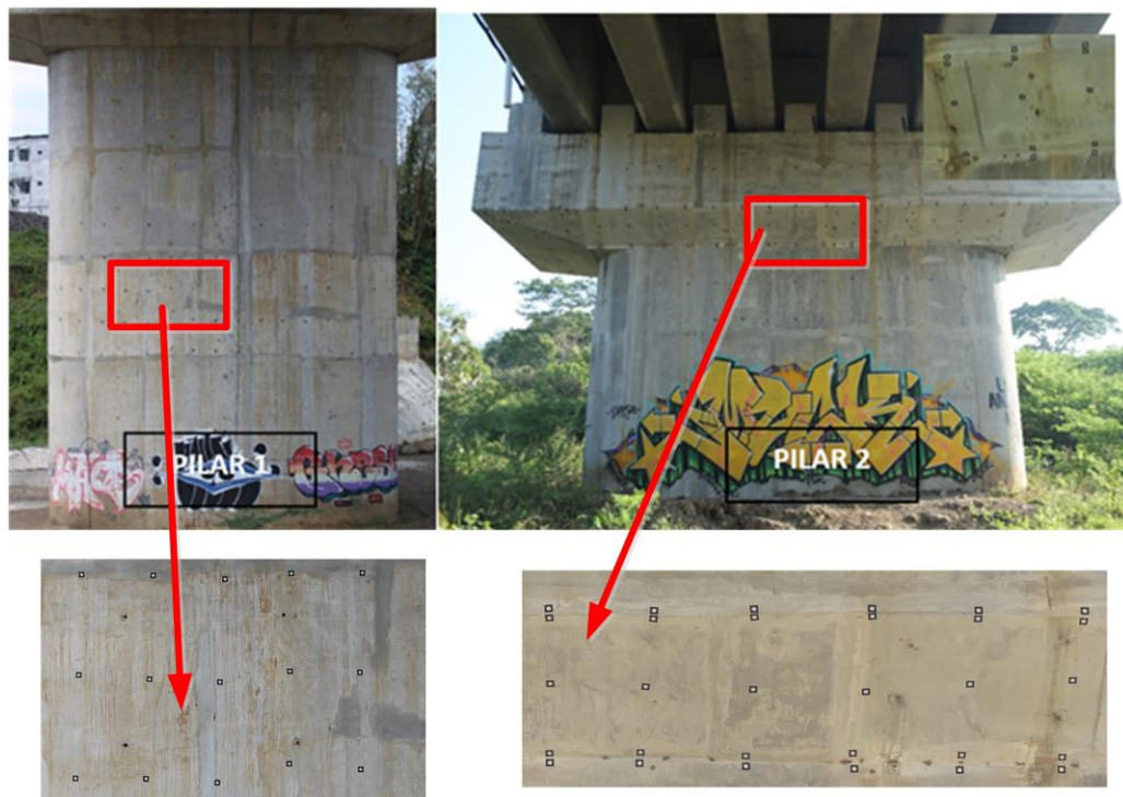
Gambar 1. Retro target yang dilekatkan pada struktur pilar
